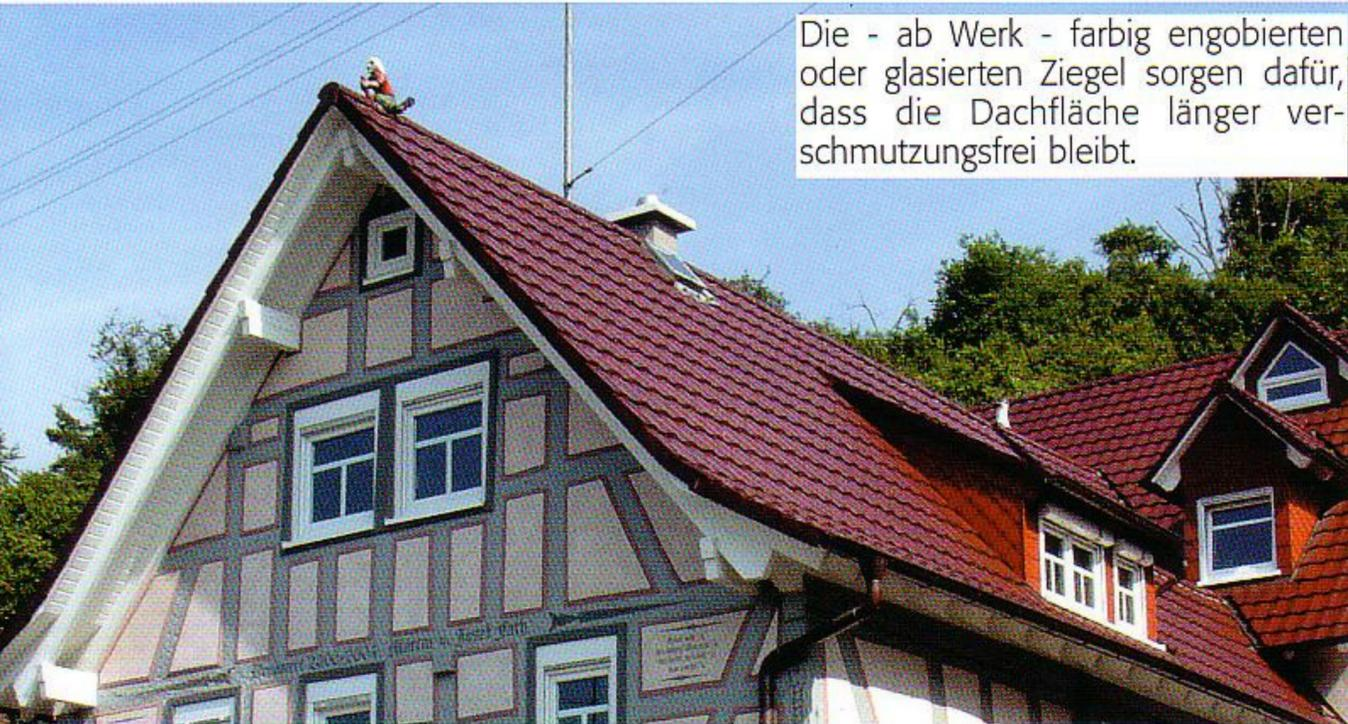
Die - ab Werk - farbig engobierten oder glasierten Ziegel sorgen dafür, dass die Dachfläche länger verschmutzungsfrei bleibt.
